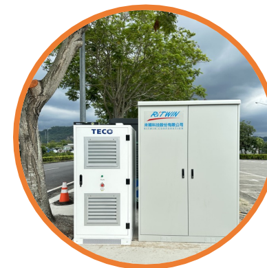
100KW/157KWh 鋰鐵電芯 (LFP)
