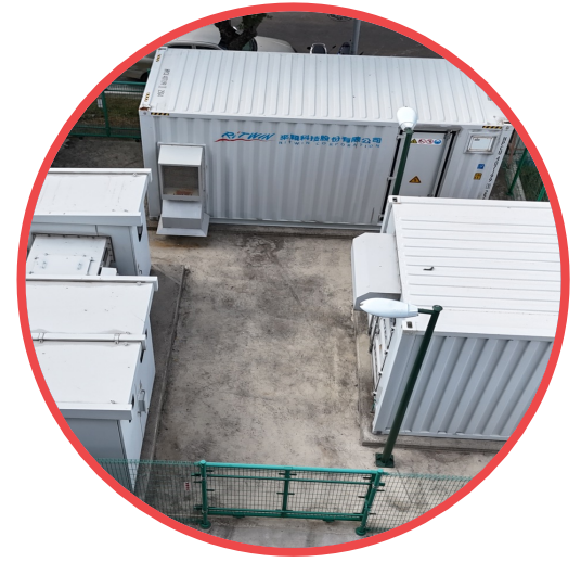
1MW/1.3MWh 鋰鐵電芯 (LFP)
