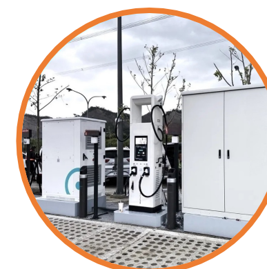
100KW/157KWh 鋰鐵電芯 (LFP)
