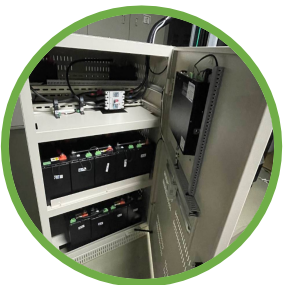
48KW/26KWh 鋰鐵電芯 (LFP)
