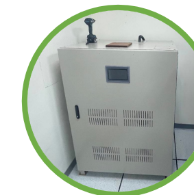
48KW/26KWh 鋰鐵電芯 (LFP)
