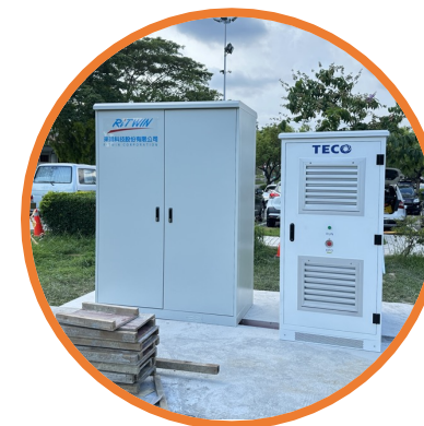
100KW/157KWh 鋰鐵電芯 (LFP)
