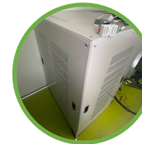
48KW/26KWh 鋰鐵電芯 (LFP)
