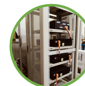
5KW/10KWh 鋰三元 (NCM)
