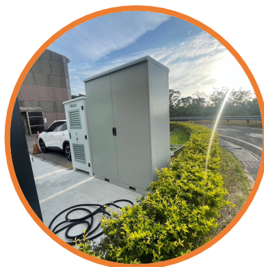
100KW/157KWh 鋰鐵電芯 (LFP)
