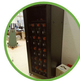
5KW/10KWh 鈦酸鋰電芯 (LTO)
