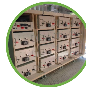
50KW/80KWh 鈦酸鋰電芯 (LTO)
