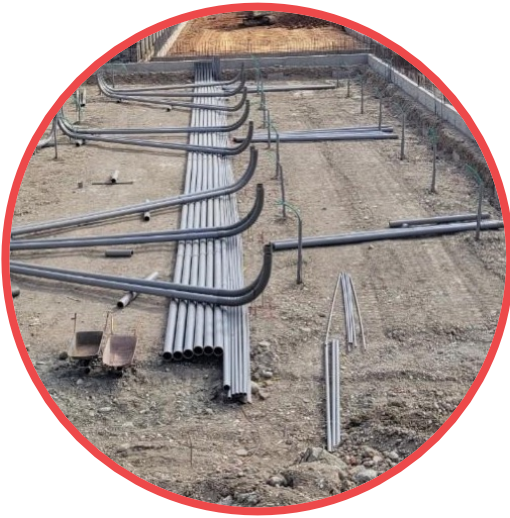
60MW/180MWh 興建中 鋰鐵電芯 (LFP)
