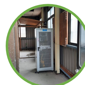
5KW/6KWh 鋰鐵電芯 (LFP)
