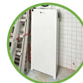
13KW/20KWh 鋰鐵電芯 (LFP)
