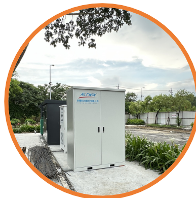
100KW/157KWh 鋰鐵電芯 (LFP)
